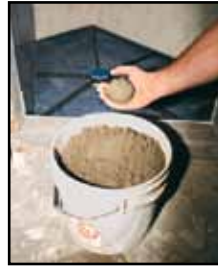
Llénelo con mezcla de cemento y arena
