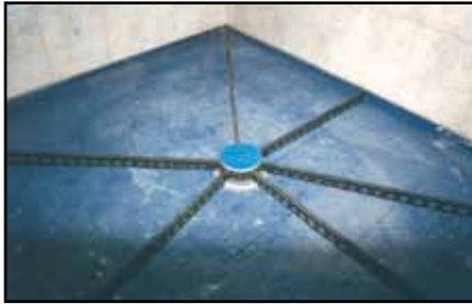
Equipo de instalación
